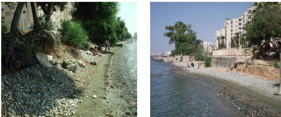
Σχήμα 2. Παραλία πριν την εκτέλεση των έργων Figure 2 Beach Area Prior to the construction of the works
